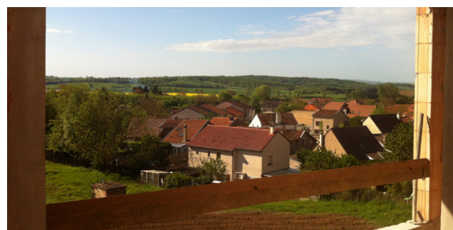
En cours de construction la vue sur le village se cadre progressivement
