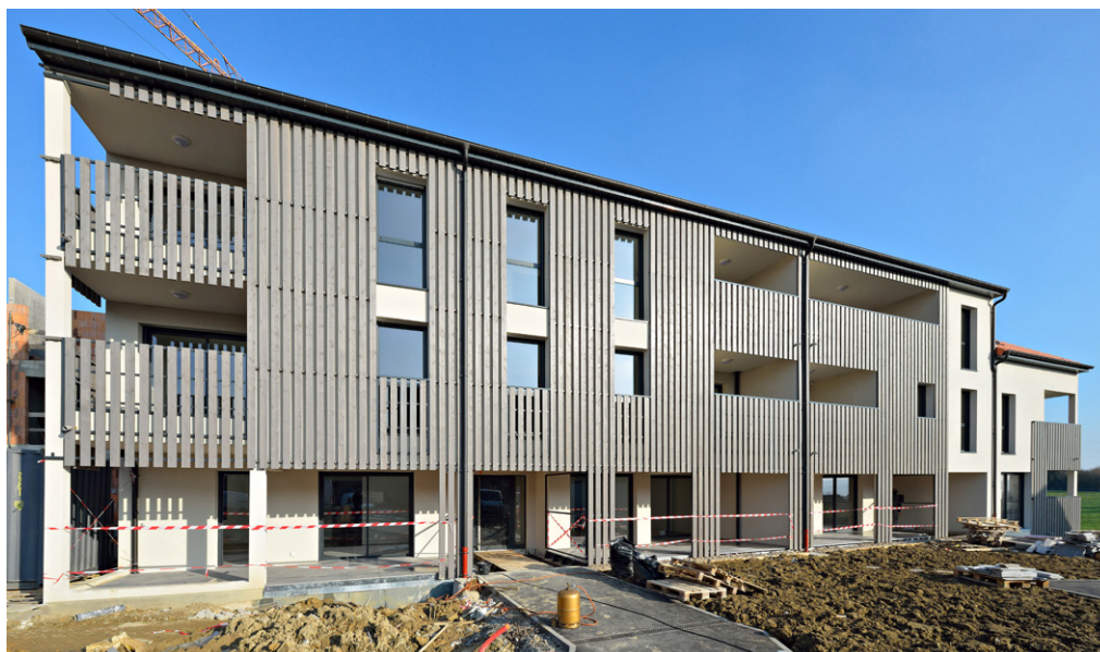
Les logements collectifs en cours de chantier
